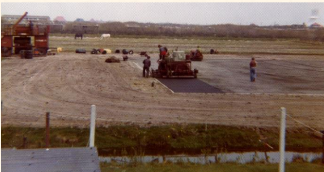
Aanleg banen in 1976
