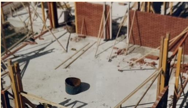
Nieuwe clubhuis in aanbouw 1981
