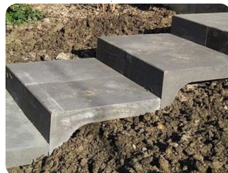
Terras begaanbaar maken met twee tredes betontegels op verschillende plekken in groenstrook. Alsook middels hellingbaan,
